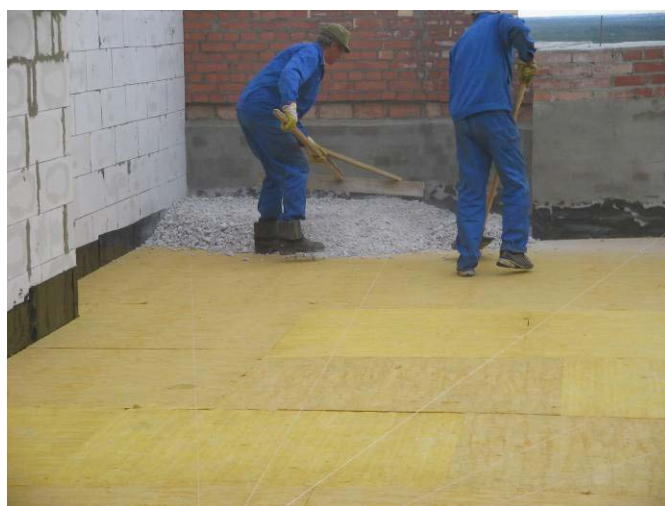
Первоначальное разравнивание – стандартным ручным инструментом
