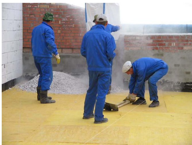
Первоначальное разравнивание – стандартным ручным инструментом
